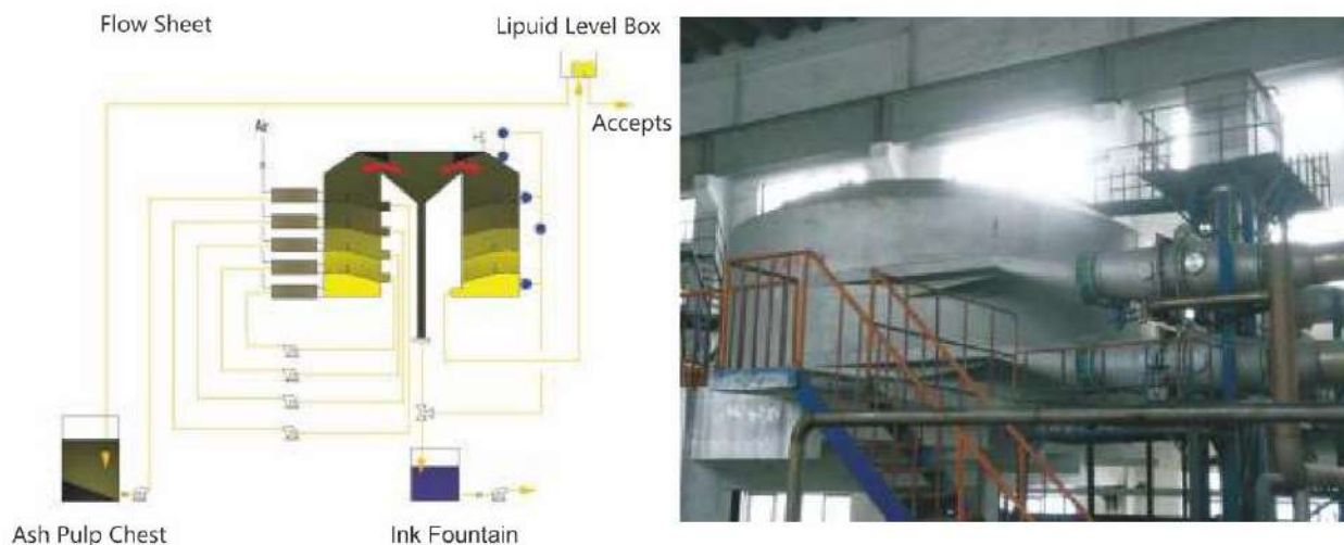
Рисунок 4.2 – Флотатор для офисной бумаги с печатью от компании Leihan
